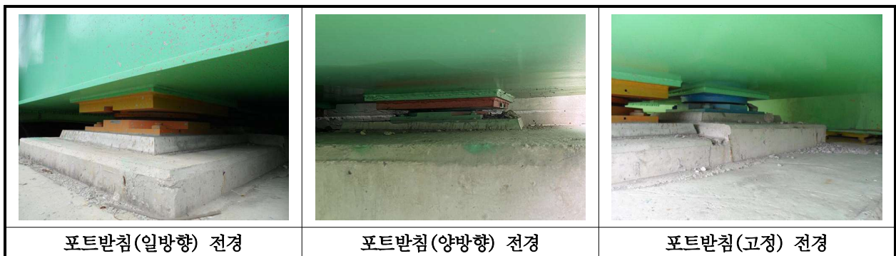
【사진 25.3.10】 교량받침 전경
