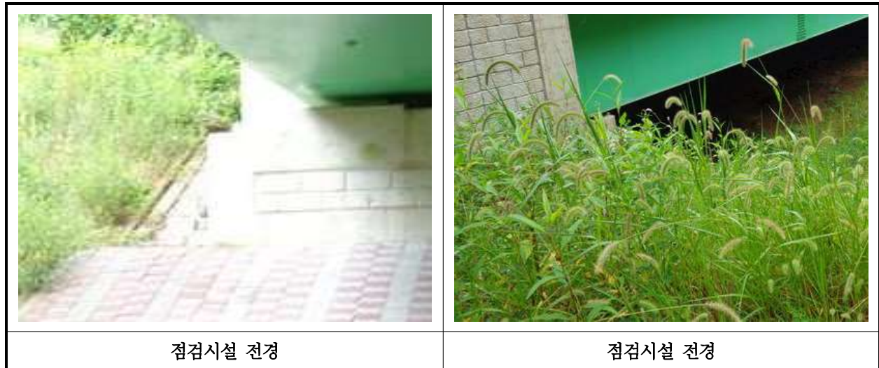
【사진 25.3.23】 교량 점검시설 전경
