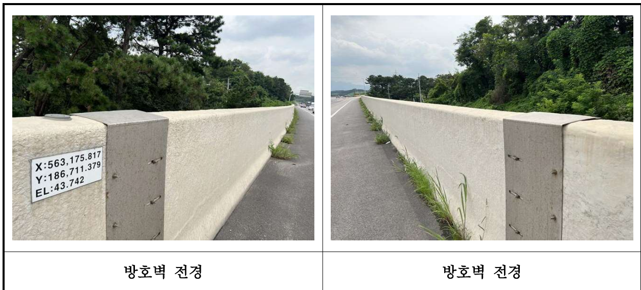
【사진 25.3.21】 방호벽 전경
