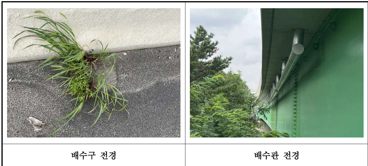
【사진 25.3.19】 배수시설 전경
