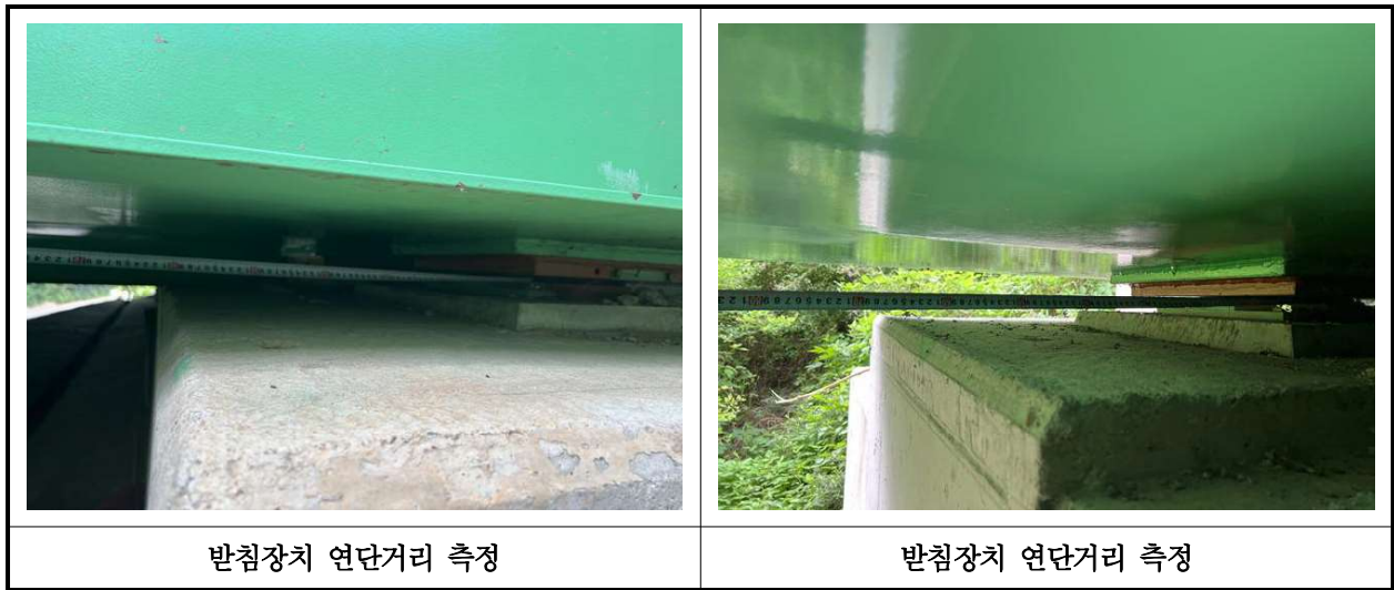
【사진 25.3.12】 교량받침장치 연단거리측정
