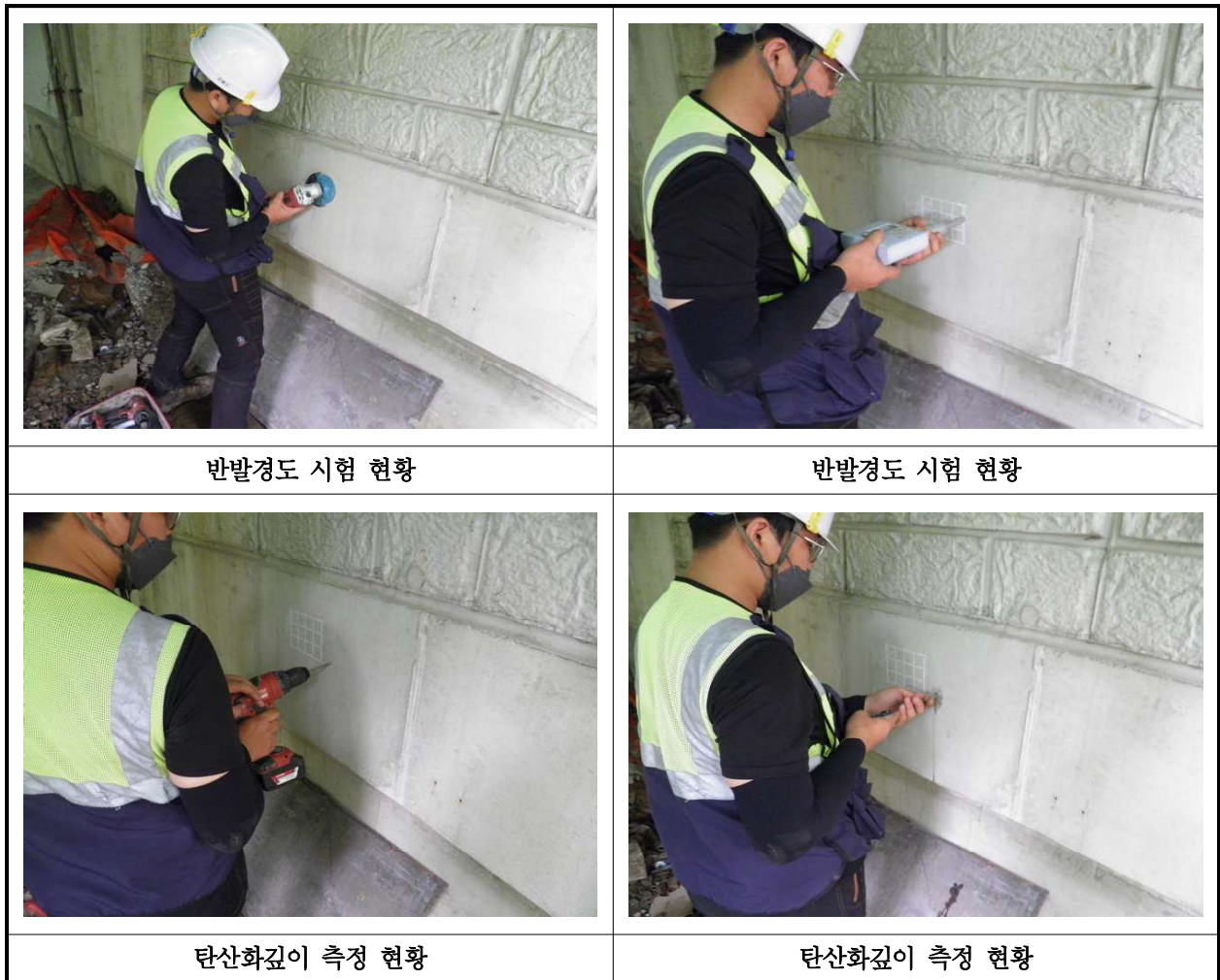
【사진 25.4.1】 콘크리트 내구성조사 현황
