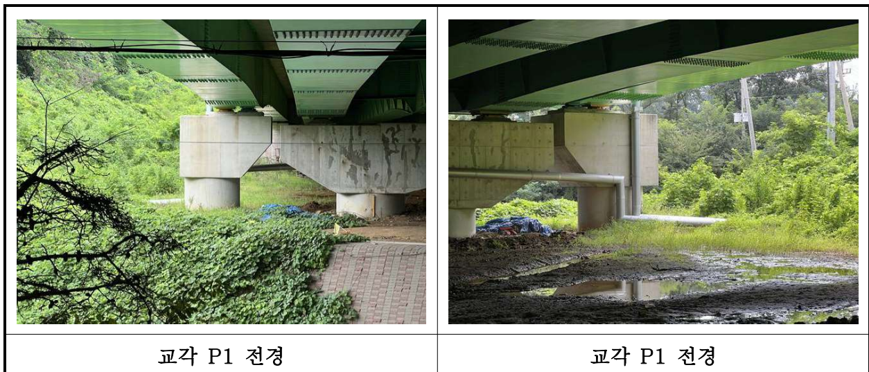
【사진 25.3.8】 교각 전경
