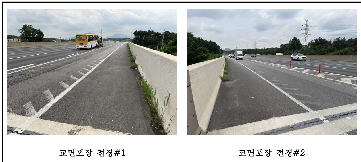
【사진 25.3.17】 교면포장 전경
