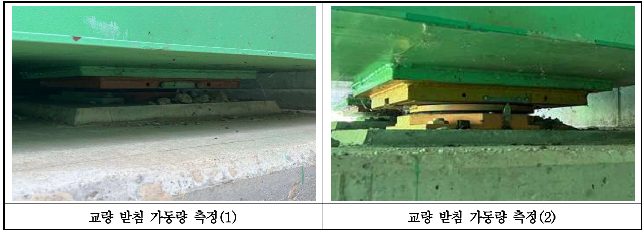
【사진 25.3.13】 교량받침 이동량 측정
