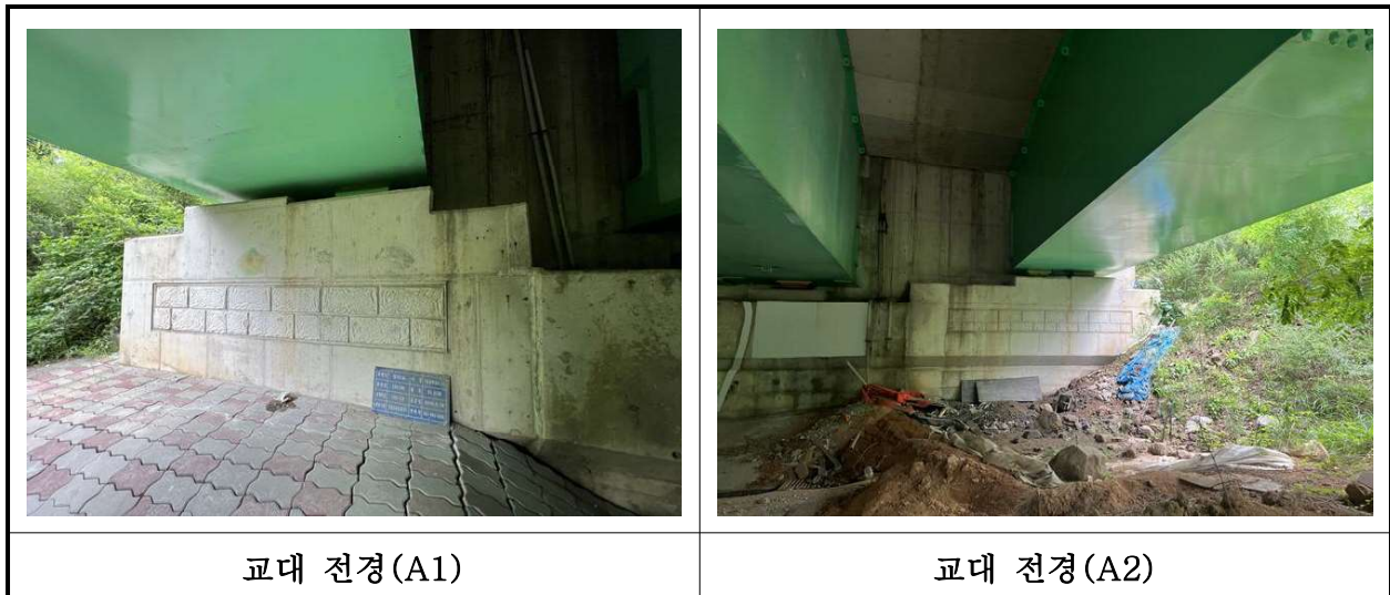
【사진 25.3.6】 교대 전경
