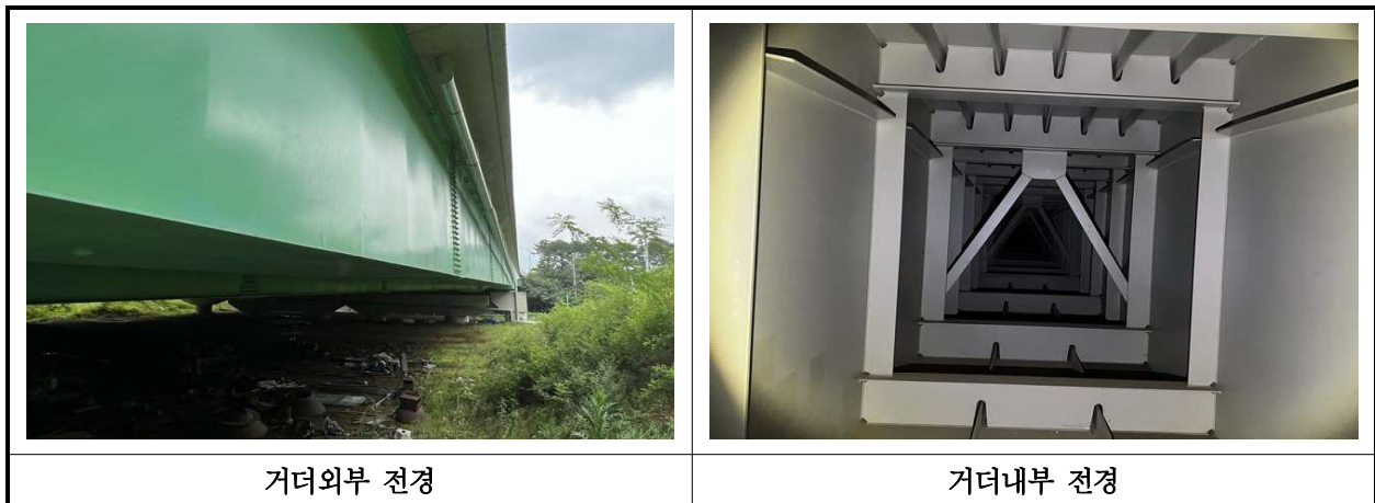
【사진 25.3.4】 거더 전경
